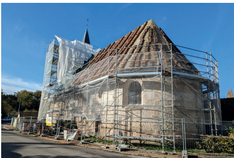
Repose des tuiles, novembre 2023
