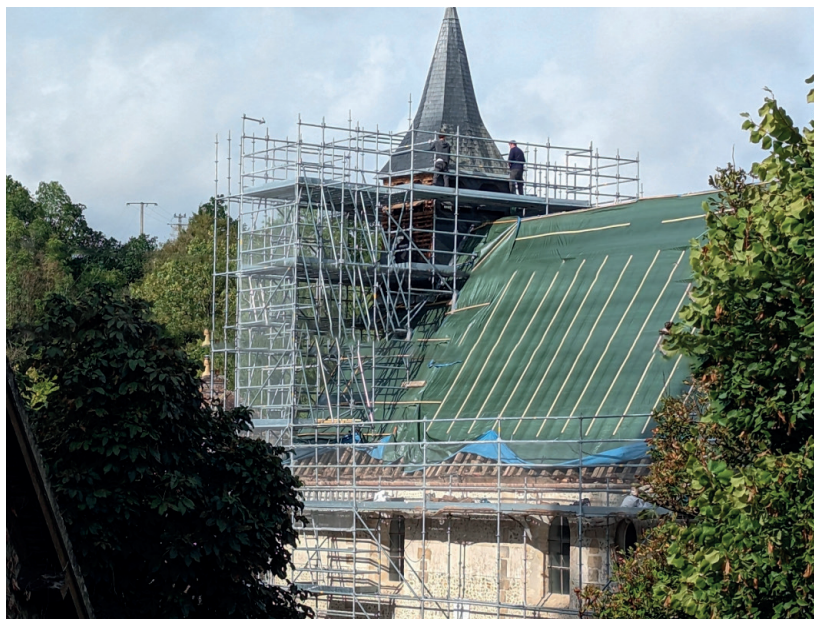
Dépose des tuiles, septembre 2023
