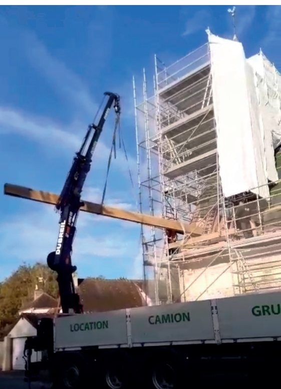
Mardi 17 octobre : ajout d'une muraille adossée au pignon pour la stabilité du clocher. Plus d'une tonne suspendue dans les airs
