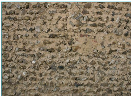
Le soubassement des murs en beuge : rognons de silex et mortier de terre crue. Laons.
