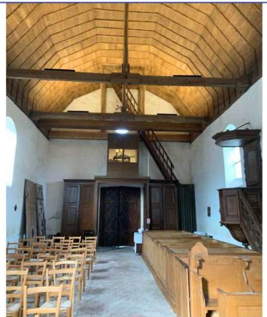
Ajout d'un poteau de descente de charge de la flèche
