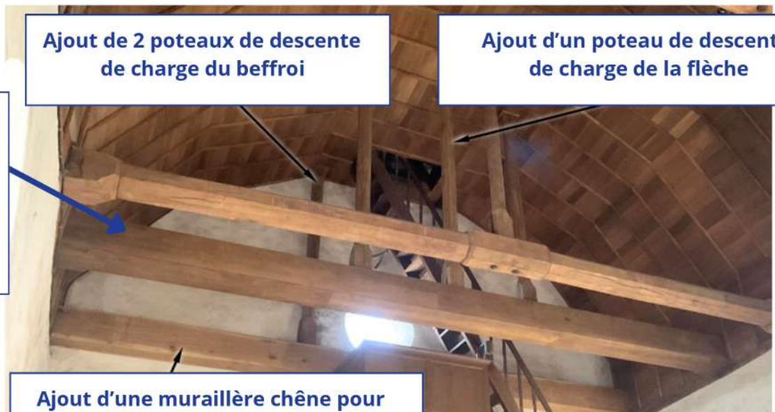
Remplacement de la poutre endommagée par une poutre HEA recouverte de chêne.
