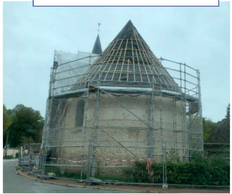
Restauration de la couverture
